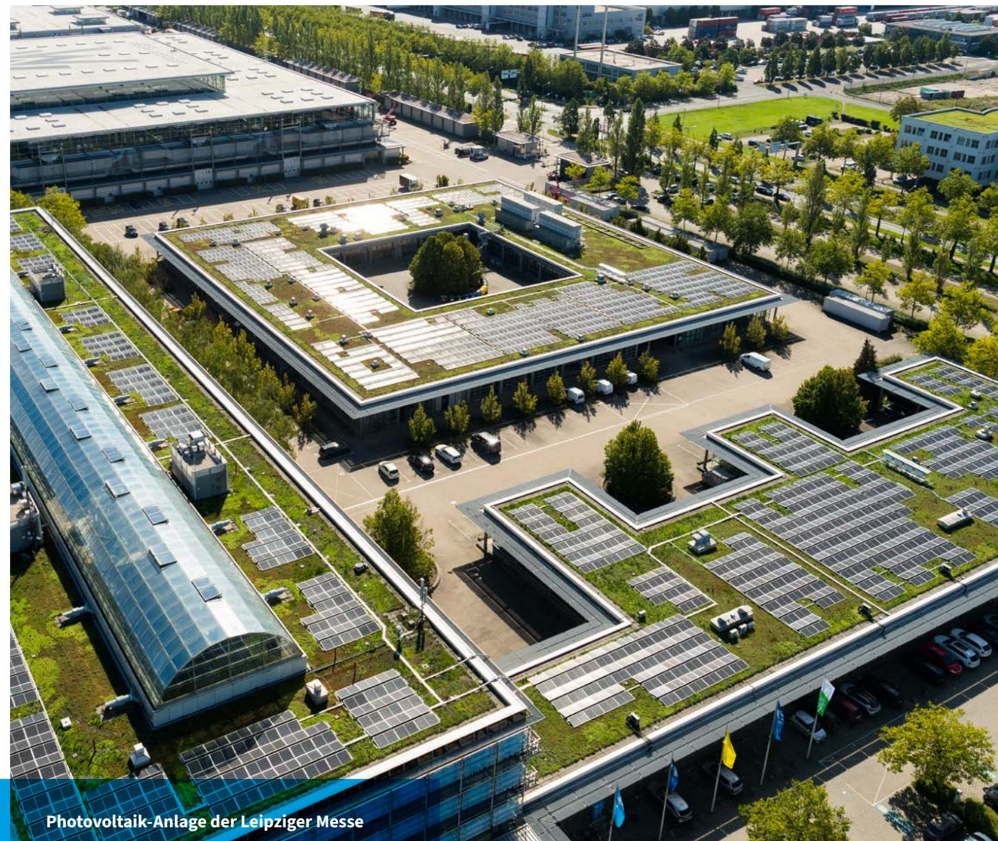
Photovoltaik-Anlage der Leipziger Messe
