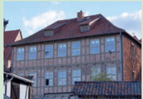
Forschungsobjekt in Quedlinburg von außen
