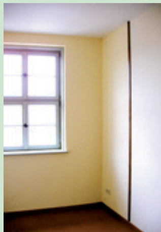
fertig sanierter Wohnraum mit Innendämmung der Außenwände
