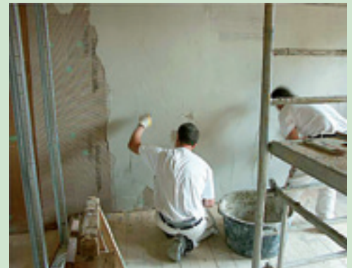
Spachtelung mit UdiMULTIGRUND® und Armierung
