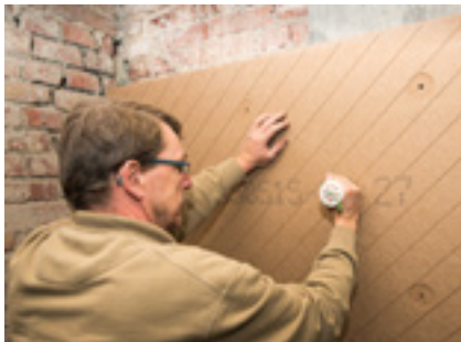
Dübel setzen
