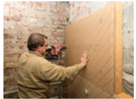
Bohren für Befestigung
