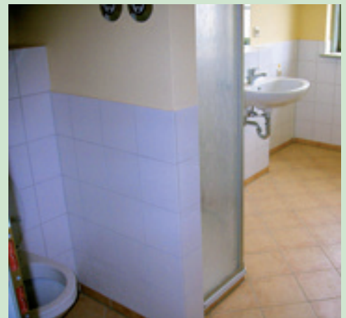
fertig saniertes Bad mit Innendämmung der Außenwände
