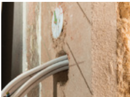
Kabel durchziehen
