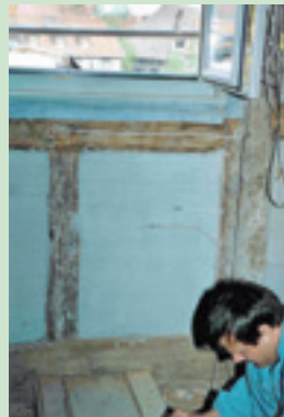
Verlegung der Messfühler
