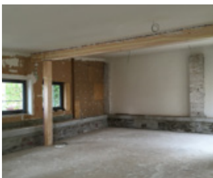
UdiSUN® im Deckenbereich verspachtelt
