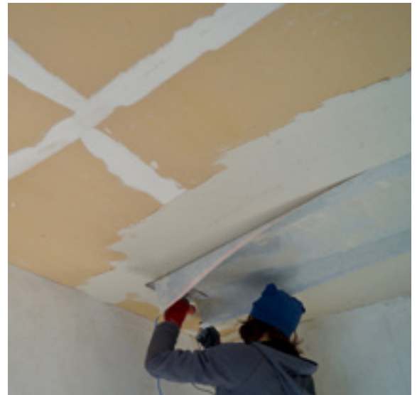
UdiSUN® beim Einspachteln
