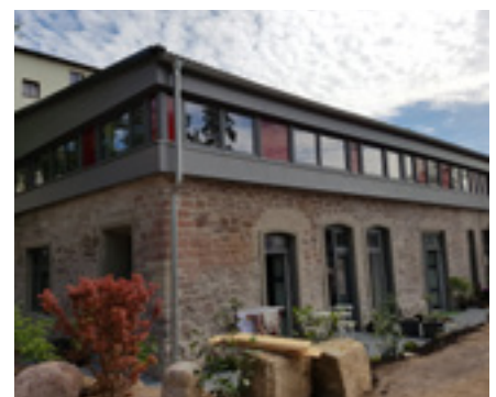
Außenansicht nach Fertigstellung
