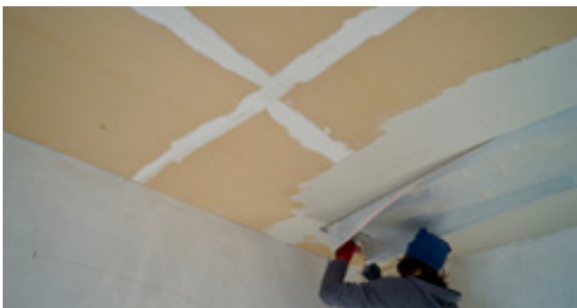
Einspachteln der Heizbahnen
