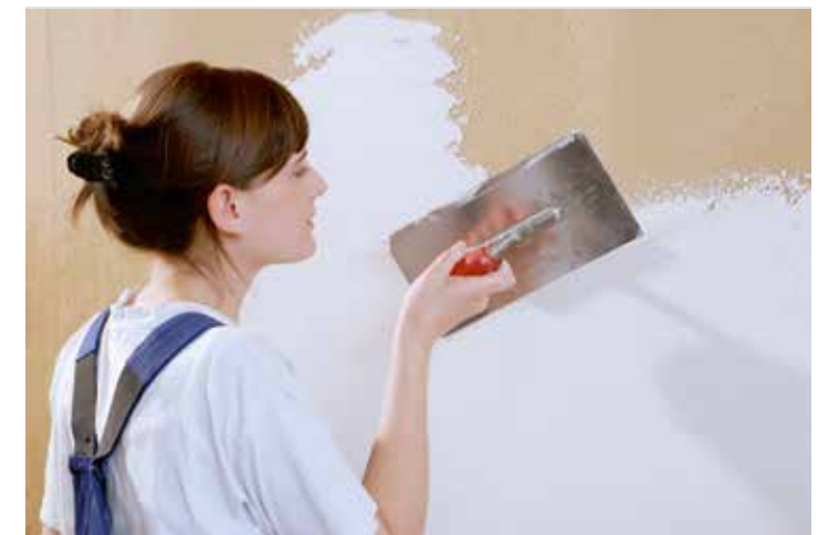
Nach dem Trocknen wird die Lehmoberfläche aufgebracht.
