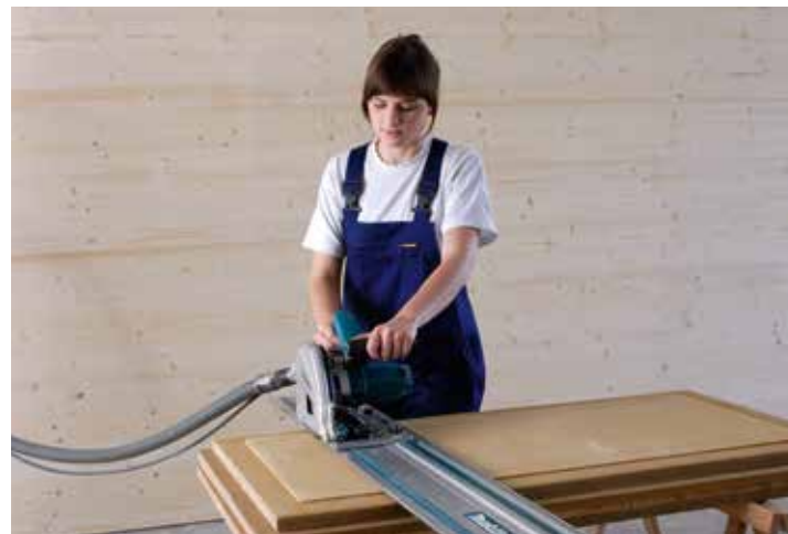
Platten ohne Heizrohr können zugenschnitten werden.
