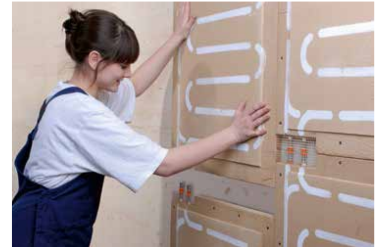
.... und dann wird die nächste Platte in die Verbindungen eingeführt.
