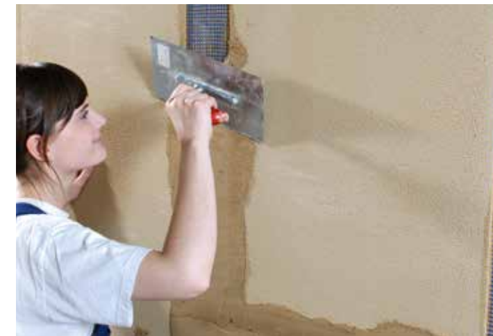
Die Flachkanten werden mit Lehm verfüllt.
