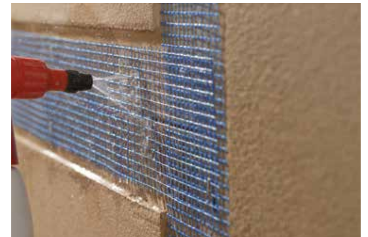
Vor dem Verfüllen werden die Flachkanten benetzt.
