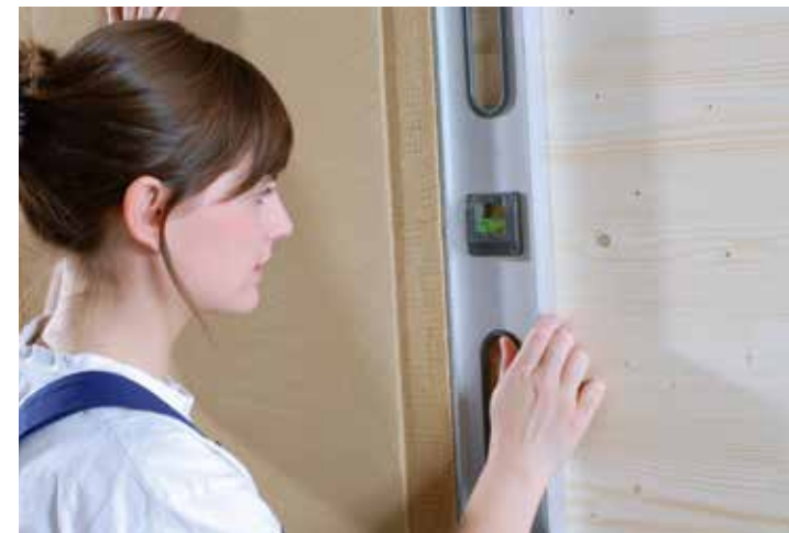
Platten werden vor der Montage ausgerichtet.
