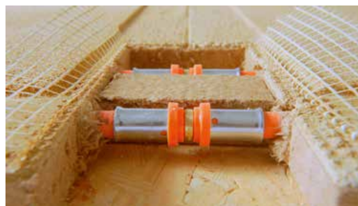
Presskupplungen verbinden die Heiz-Kühlplatten.
