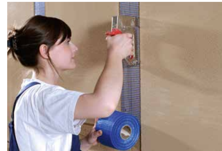
In die Flachkanten wird ein Gewebe getackert.
