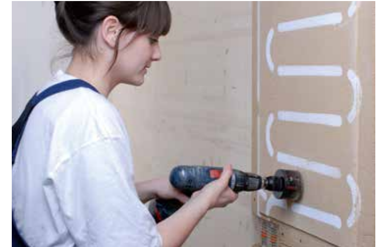
Unterputzdosens können zwischen den Rohren montiert werden.
