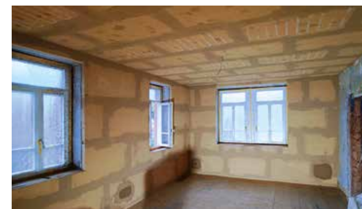
Nach der Plattenmontage und vor dem Finishputz
