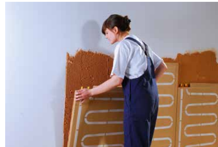
Platten werden vor der Montage ausgerichtet.
