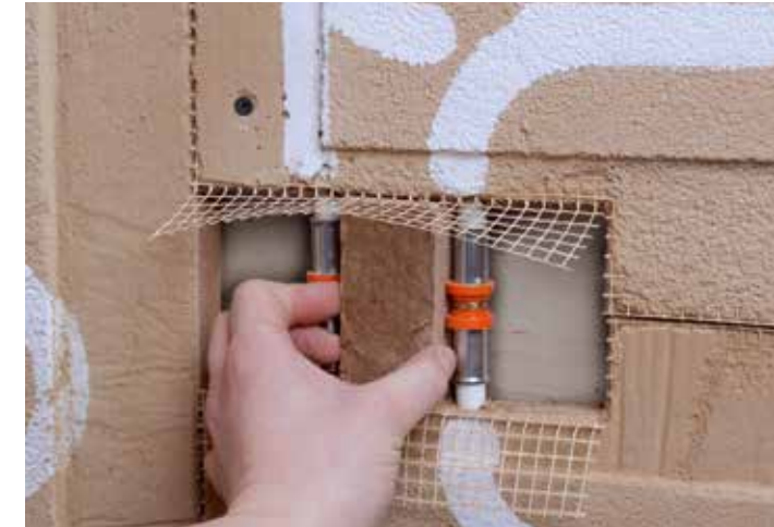
Nach dem Verpressen werden die Lücken gefüllt.
