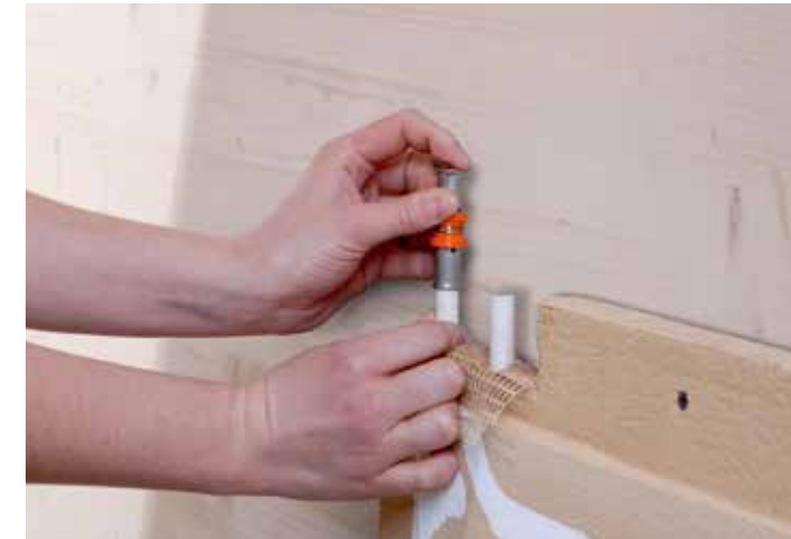
Bei Heizplatten werden die Verbindungsstücke aufgesetzt
