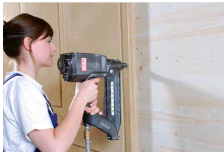
Die Platten können auf Ständerwerk oder Vollholz geschraubt und auf Mauerwerk geklebt werden.
