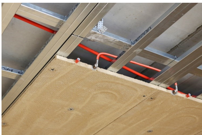
Abb 2: WEM Klimadecke aus Lehm im Industrie-/Bürogebäude
