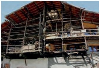
Das Verfahren basiert auf dem biologischen Prinzip, dass Insekteneiweiß bei einer Temperatur von 50-55°C denaturiert wird. Nach Erreichen dieser Temperatur in allen Holzteilen werden sämtliche Insekten in allen Stadien sicher und nachhaltig abgetötet. Das Verfahren arbeitet nur mit warmer, feuchtegeregelter Luft, 100% ökologisch und giftfrei.
