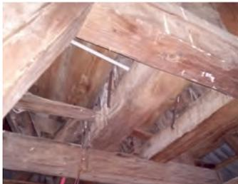
Im Unterschied zum klassischen Heißluftverfahren, arbeitet das Thermo Lignum® WARMAIR Verfahren für Gebäude mit niedrigeren Raumtemperaturen von 65-75°C (max. 85°C) und – wenn notwendig – mit einer zusätzlichen Befeuchtung der Raumluft. Dadurch wird das Risiko von Beschädigungen von Bauteilen und Leitungen stark reduziert.
